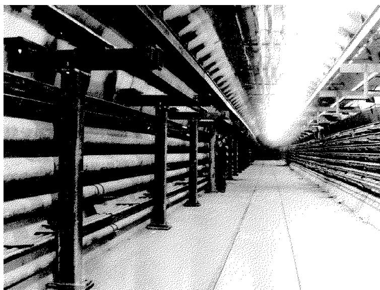
Рис.2. Участок тоннеля, подготовленный к монтажу оборудования.
