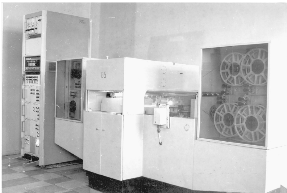
Рис. 2. Внешний вид (фото) оптико-механической части проектора ПУОС-4.
