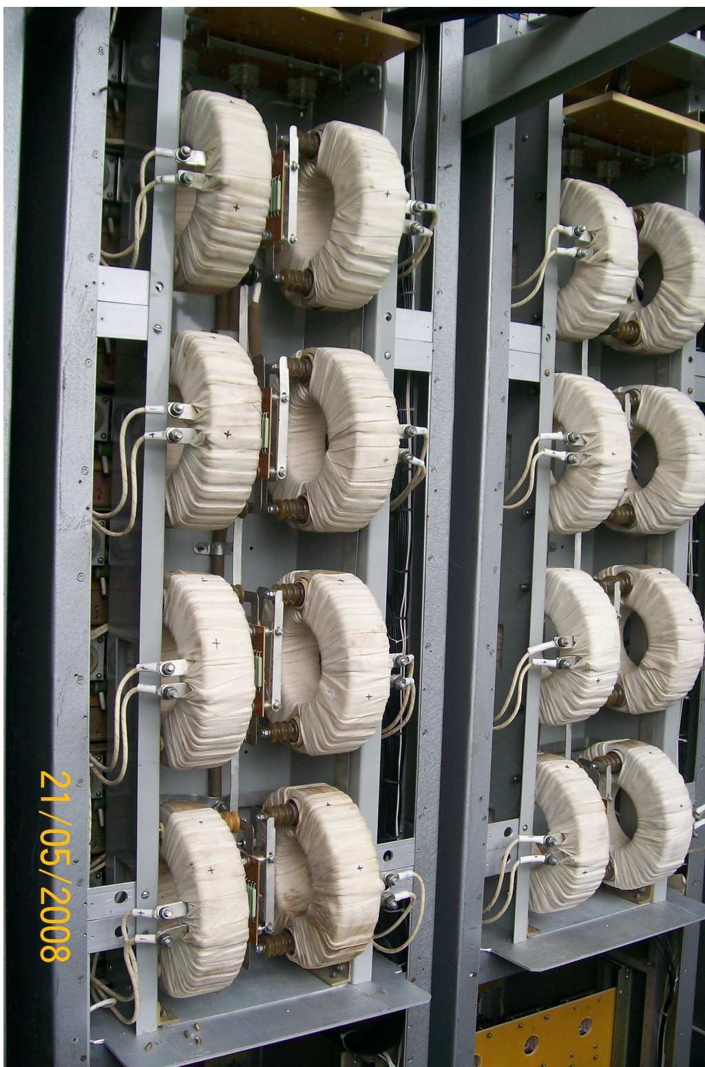
Рис. 16. Размещение силовых трансформаторов в стойках (обратная сторона).
