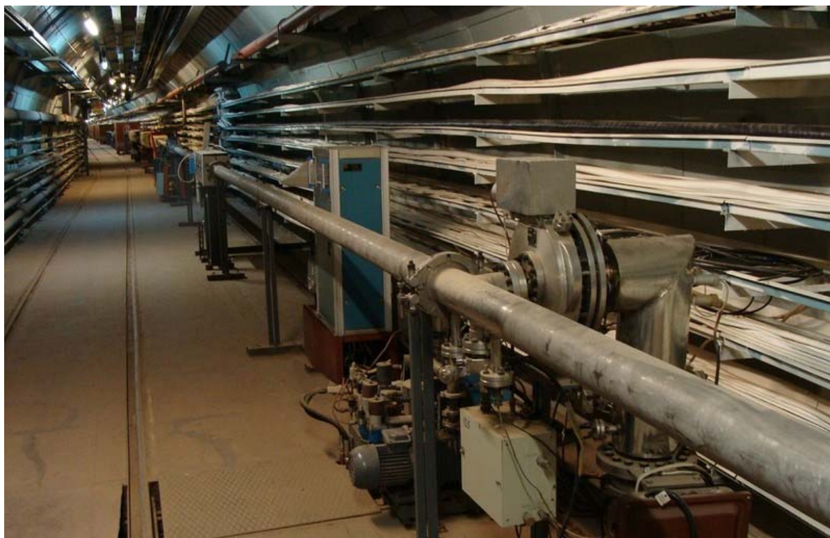
Рис. 1. Участок канала транспортировки протонов с постом предварительной откачки.
