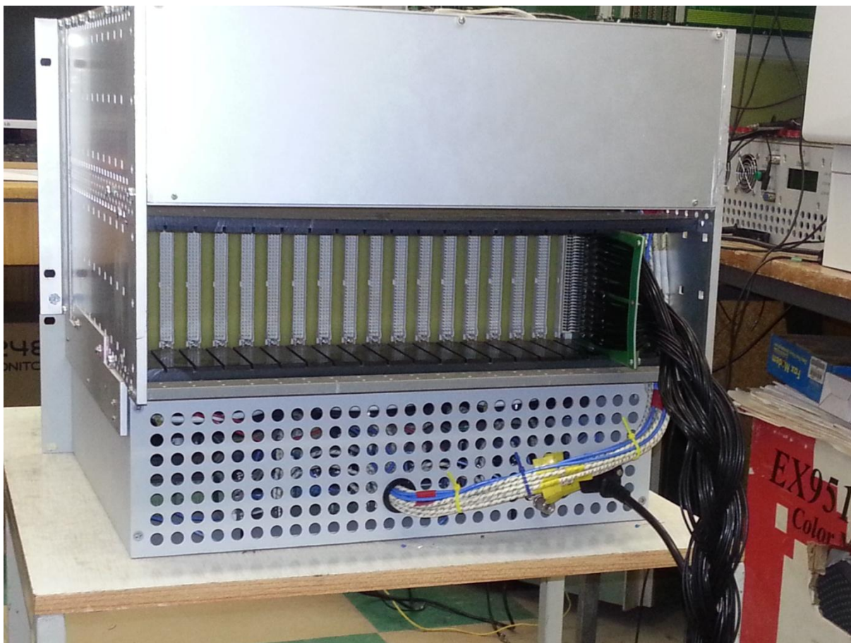
Рис 7. Вид сзади каркаса с EM-6. Показано подключение сигналов от детектора к одному из модулей.
